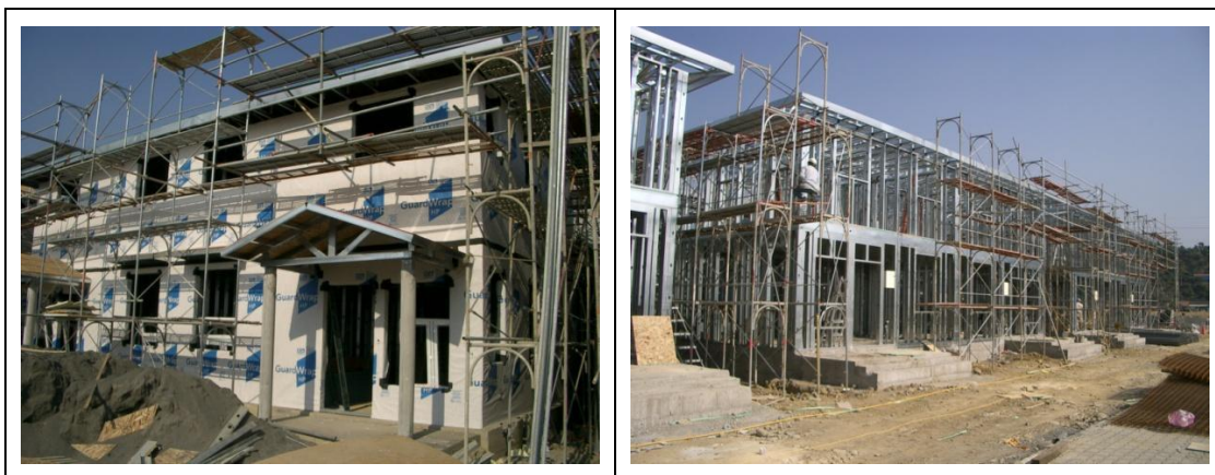
圖-3 理成鋼構公司所興建冷軋輕型鋼構建築(88水災-慈濟永久安置屋)
