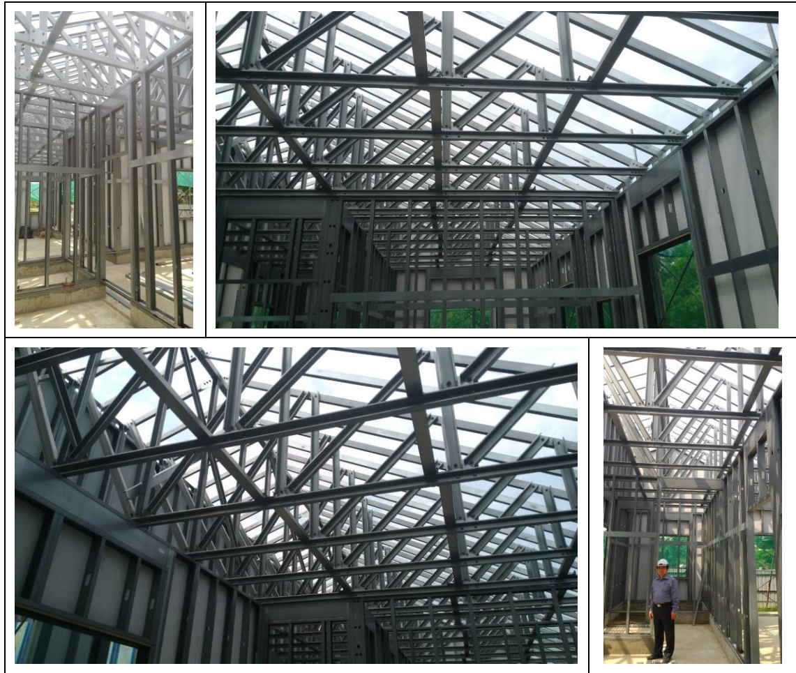
圖-4 台日公司所興建冷軋輕型鋼住宅
