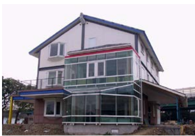
圖 2-4 臺灣大學設置的綠房屋
